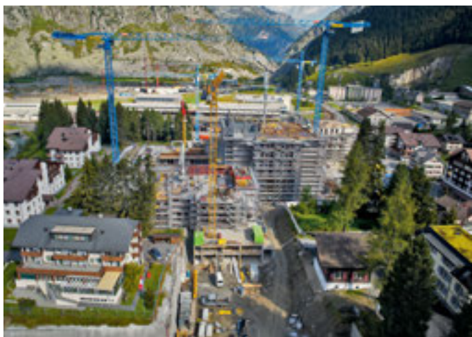
Der Bauplatz für das Hotel The Chedi liegt im Park des ehemaligen Hotels Bellevue direkt neben dem Bahnhof.
