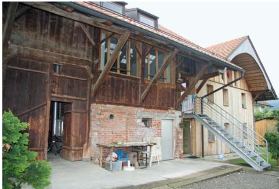
Der Eigentümer entschied sich von Anfang an gegen das künstlich Alte und liess in der Scheune moderne und funktionale Wohnungen einbauen (Bild C. Crausaz)
