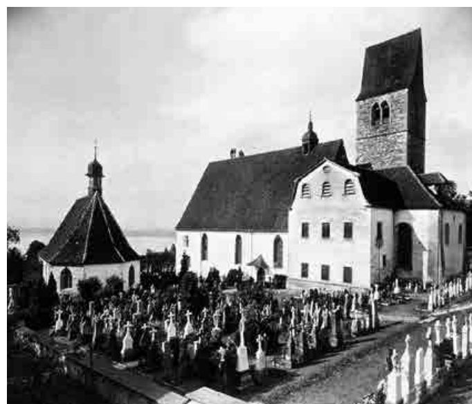
Der Friedhof im Bereich der alten Kirche St. Michael und des Beinhauses St. Anna. Bis in die zweite Hälfte des 20. Jahrhunderts erfolgten üblicherweise Erdbestattungen mit Grabsteinen. Aufnahme 1890–1898.
