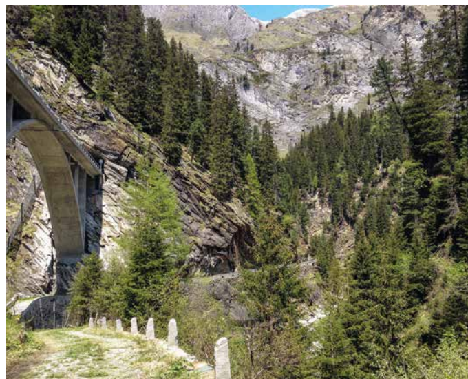
En contrebas le pont de la Valle di Lei de l'ancienne route de la vallée d'Avers (1895) et au-dessus l'arche du nouveau pont en béton.
