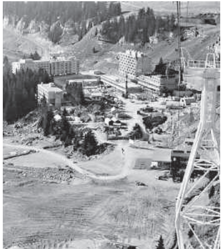
Blick auf die Baustelle des Wintersportortes Flaine in Hochsavoyen, (1969) (Bild Archives G. Chervaz)
